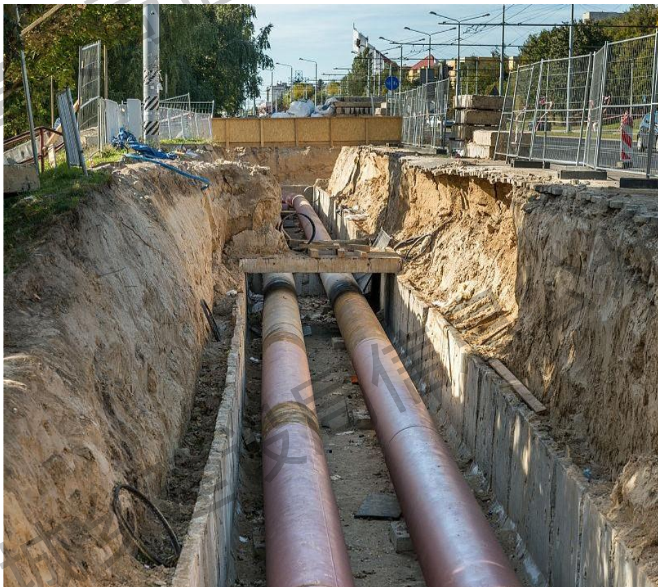
老旧地下管网改造
